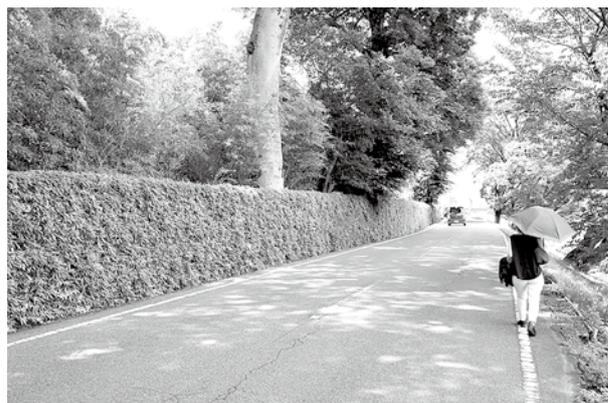
離宮東側の独特な垣根で、日本人が実践してきた ECO-DRR（生態系を利用した防災・減災）の実例である。この地域は、もともと桂川（道路の右側）の氾濫原で洪水対策が離宮成立の必要条件だった。庭園や建物に致命的なダメージを与えるのは、洪水によって運ばれた土砂の堆積であって、水そのものではない。そこで、土砂の流入を防ぐ目的で、この垣根が考え出された。まず、桂川に沿って竹藪（垣根の背後）を育成。次に、その竹をそのままほぼ直角に折り曲げて固定し、生垣に仕立てている。もし洪水が起こっても、密生する笹の葉がフィルター役目をして土砂をここでブロックし、庭園には水だけが流入する仕組みである。無理やり曲げられた竹は割れることも多いが、枯れることはない。防災・減災と植物の知識を融合させ、美的にも優れた工夫である。
